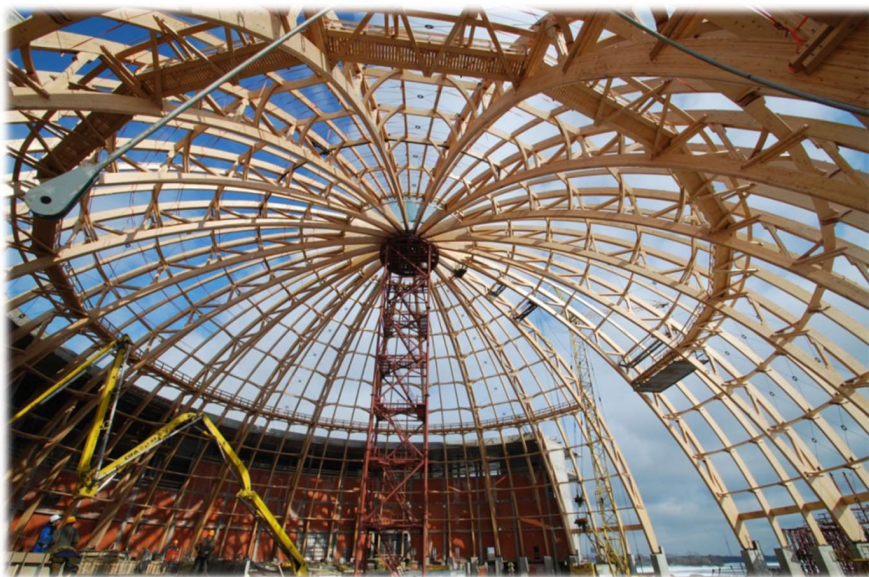
Рис. 1. Реальная конструкция деревянного купола
