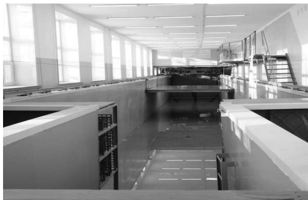
Рис. 1. Чаша опытового бассейна КНАГТУ в осушенном состоянии
