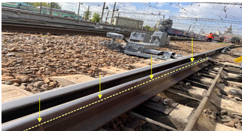
Рис. 2. Силы воздействия колеса на острьяк стрелочного перевода
