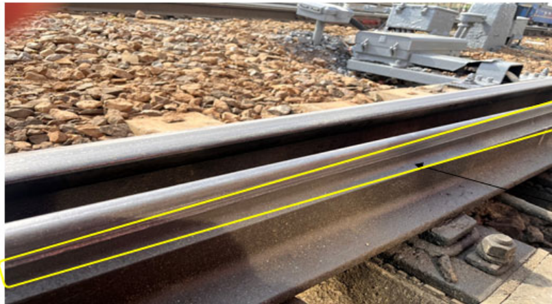
Рис. 3. Дефекты в виде наплыва на острейке, требующие механической обработки
